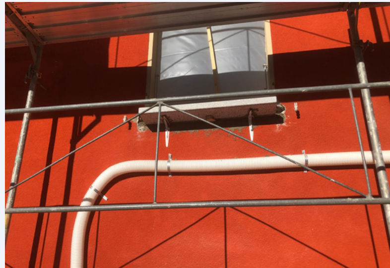
L'épaisseur des murs de la maison a augmenté de 20 cm dans le processus d'isolation, les tuyaux du nouveau système de ventilation sont installés dans la couche d'isolation.
