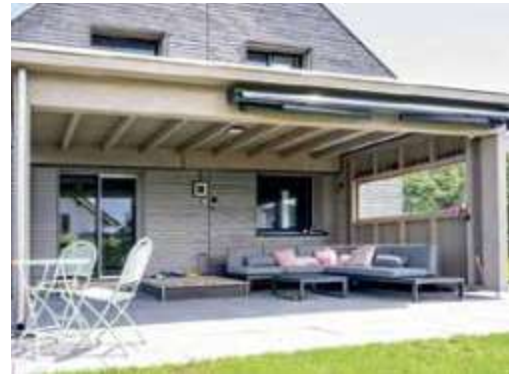
Für den Umbau erhielt die Familie Fördergelder aus dem Gebäudeprogramm.
