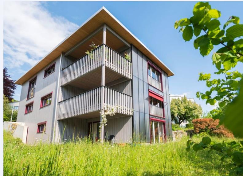
Der Dachstock wurde durch einen Holzaufbau ersetzt und zu einer Familienwohnung ausgebaut, im hangseitigen Untergeschoss entstand ein Studio.
